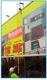
Existen postes telescópicos en el mercado que le permitirán enganchar un dispositivo de detención de caídas retráctil o una línea de vida vertical desde el suelo a un punto de anclaje seguro preexistente.
