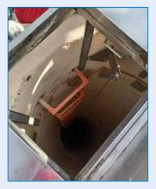
Si tienes que acceder a un espacio confinado y existe riesgo de caída, antes de bajar por la escalera instala un sistema anticaídas (ejemplo: dispositivo retráctil anclado a un trípode, línea de anclaje vertical...).
