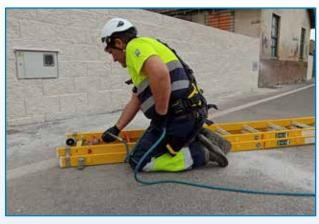
El sistema de detención de caídas que vas a utilizar para trabajar en la escalera debe permitirte instalarlo desde el suelo.
