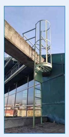
Si va a utilizar una escalera fija, valora la necesidad de utilizar un sistema anti-caídas.
