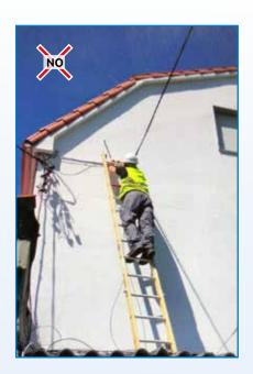
La escalera debe estar nivelada y apoyada sobre una superficie lo suficientemente firme para soportar el peso que llevará: no apoyarla sobre elementos frágiles (techos de fibrocemento...), inestables (cajas, bidones...) o móviles.
