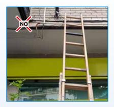
Antes de colocar una escalera ¡MIRA A TU ALREDEDOR! Comprueba que no existen peligros que puedan afectar a tu seguridad: tráfico (a pie o en vehículos), puertas que dan a las escaleras, conductores eléctricos...
