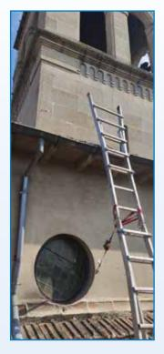
Comprueba que la hayas estabilizado correctamente, que las zapatas de apoyo no resbalen y que esté asegurada contra vuelcos. Si la amarras aumentarás tu seguridad.
