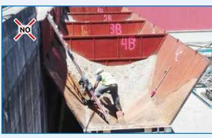
Utiliza escaleras con patas antideslizantes y evita apoyarlas sobre superficies sucias o resbaladizas (materiales sueltos, superficies pulidas, líquidos derramados...).
