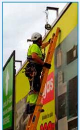
Si no te resulta fácil disponer de puntos de anclaje seguros y tienes que realizar trabajos a gran altura y/o con movimientos frecuentes, intenta utilizar otros medios más seguros (pemp...).
