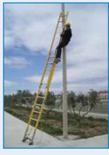
Si vas a realizar trabajos desde una escalera a más de 3,5 metros de altura, que requieran movimientos o esfuerzos desestabilizadores (trading, uso de llaves...) y no es factible utilizar otro equipo más seguro, hazlo solo si dispones de un sistema anticaídas adecuado. Asegúrate de que el punto de anclaje sea seguro y accesible.
