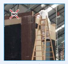
Si trabajas con herramientas, asegúrate de estar en una posición estable.
