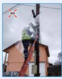
No la utilices en exteriores con condiciones climáticas adversas como viento fuerte, lluvia...
