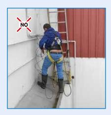
Si la colocas cerca de huecos o desniveles, deberás disponer de sistemas de protección adicionales (cubriendo el desnivel, redes de seguridad, uso de protección individual...).
