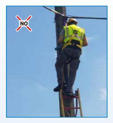
No subas demasiado alto: la parte superior de la escalera debe estar a la altura de la cintura para que pueda sostenerte fácilmente si es necesario.
